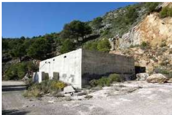
Depósito de la Cantera (M. Limón Andamoyo, enero 2020)
