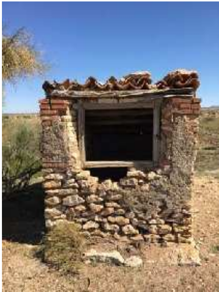
Aljibe Cortijo Becerra, brocal registro para sacar agua. IV (J. M. Fernández Palacios, octubre 2019)
