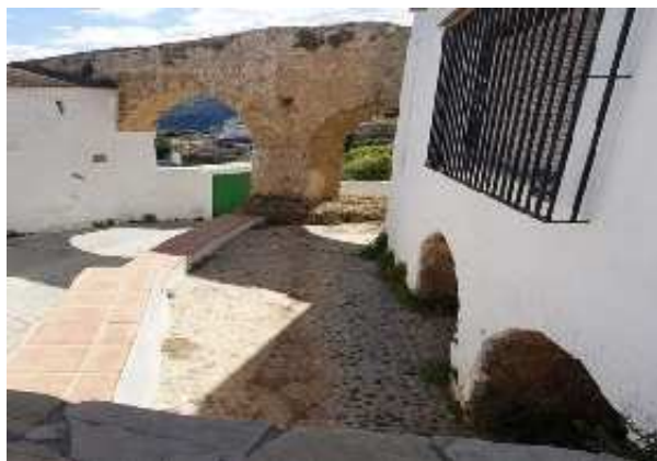
Molino y Acueducto de los Patos (M. Limón Andamoyo, abril 2019)
