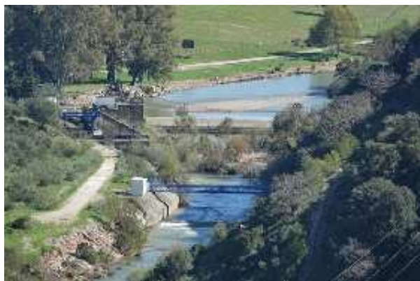
Presa de Las Buitreras, vista general (M. Limón Andamoyo, junio 2015)
