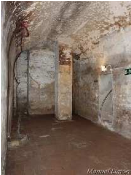
Aljibe de la Casa del Pirata (M. Limón Andamoyo, julio 2017)
