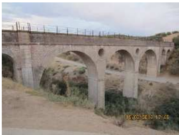
Acueducto del Canal de Cacán en Cíjuela (J. Laserna Jiménez, febrero 2017)
