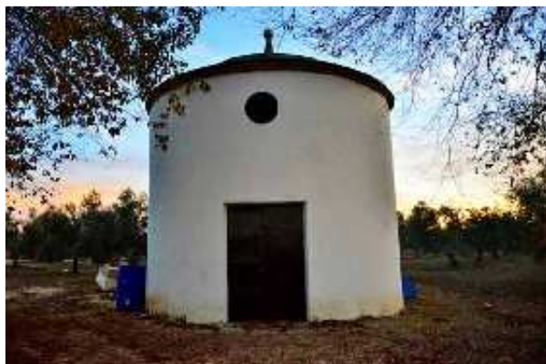
Pozo del Término (J. Torres Garrido, diciembre 2016)
