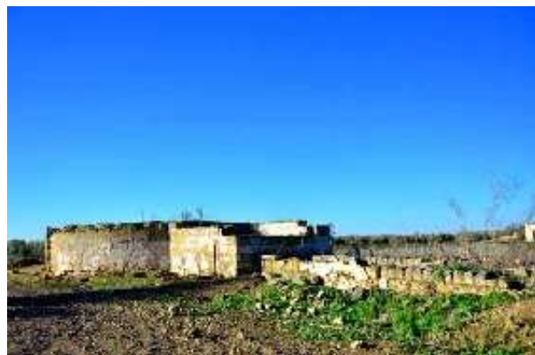
Pozo noria del Alamillo (J. Torres Garrido, diciembre 2016)
