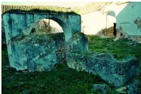
Pozo del Arenoso (J. Torres Garrido, diciembre 2016)
