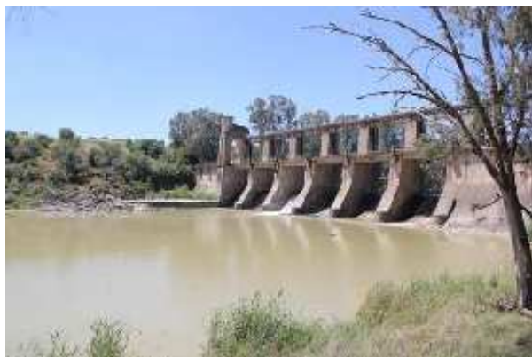
Presa El Salto (J. A. Palomino León, noviembre 2016)
