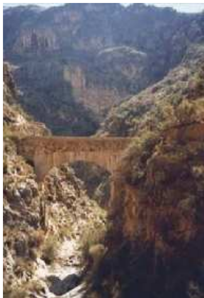
Acueducto de los Poyos ( www.juntadeandalucia.es )
