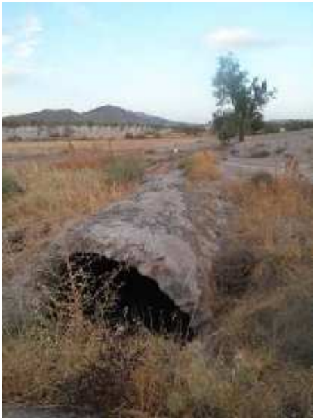
Aljibe del Ventorrillo (T. Peinado Parra, octubre 2016)
