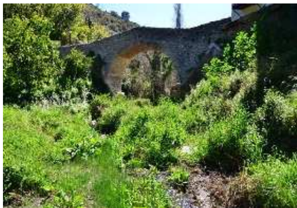
Puente árabe de Salares (J. Torres Garrido, octubre 2016)
