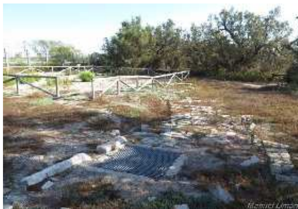
Aljibe de la Estación de Empalme (M. Limón Andamoyo, septiembre 2016)
