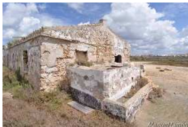
Aljibe de la Casa Salinera San Miguel (M. Limón Andamoyo, agosto 2016)
