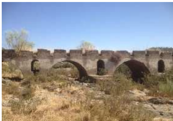
Puente sobre el río Sillo (J. M. Fernández-Palacios, agosto 2016)
