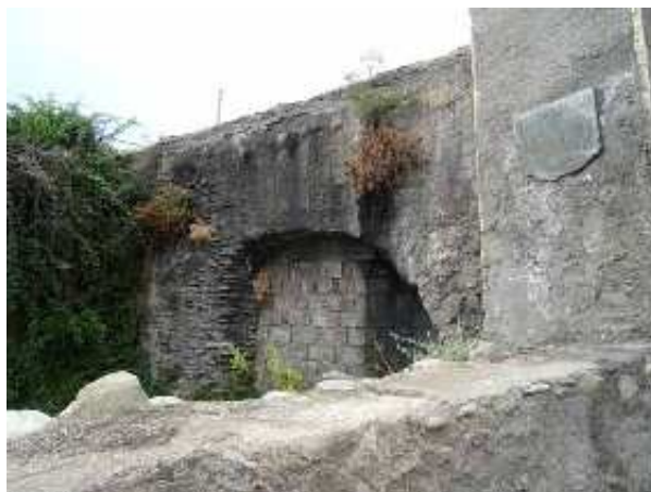
Acueducto de la Noria (J. Laserna Jiménez, julio 2016)
