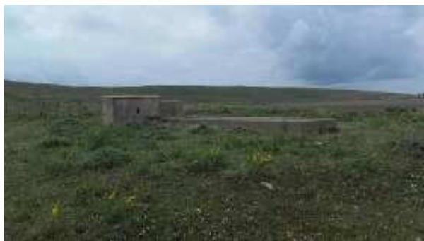
Pozo Marismas del Barbate (M. Barcell, mayo 2016)
