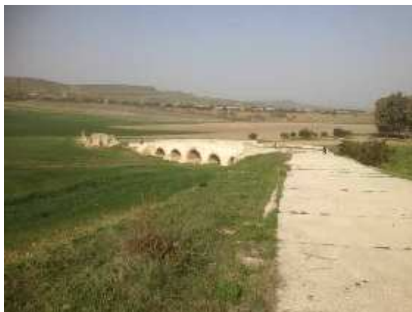
Puente de los Cinco Ojos (J. M. Fernández-Palacios, febrero 2016)
