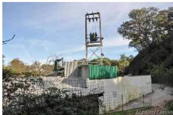
Molino de Escalona reconvertido en central eléctrica (M. Limón Andamoyo, enero 2016)
