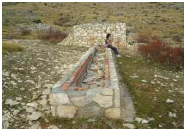
Aljibe de la Cañada de las Cruces (J. A. Palomino, julio 2013)
