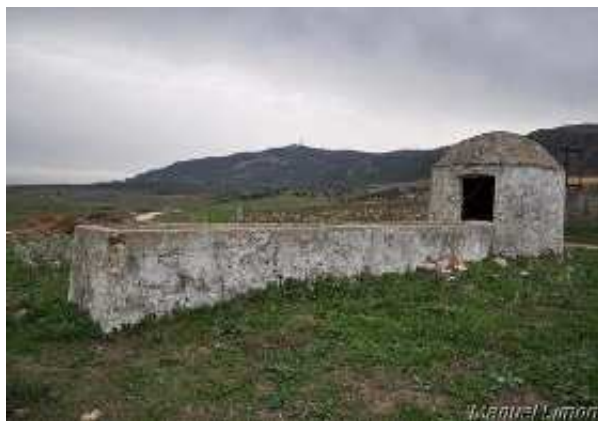
Aljibe de la Cortijada del Moro (M. Limón Andamoyo, enero 2016)
