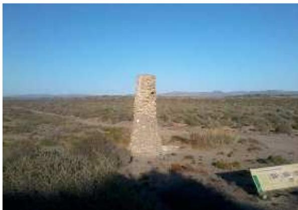
**Perspectiva general del pozo, donde se observa su gigante brocal. En la parte superior, se ve un agujero, correspondiente a la primera boca del pozo, cuando el suelo de la rambla estaba a niveles supe**
