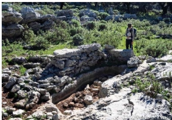
Pilón de El Chaparral (M. Limón Andamoyo, noviembre 2015)
