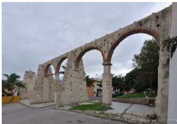
Acueducto de la Bajadilla (M. Limón Andamoyo, noviembre 2015)
