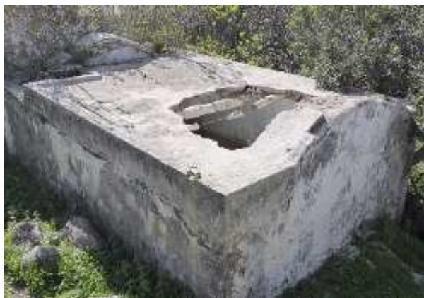
Aljibe de la Casilla las Latas (P. Sánchez Gil, abril 2015)
