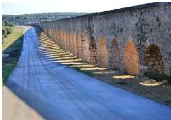
Acueducto de Caramago (J. Torres Garrido, diciembre 2014)
