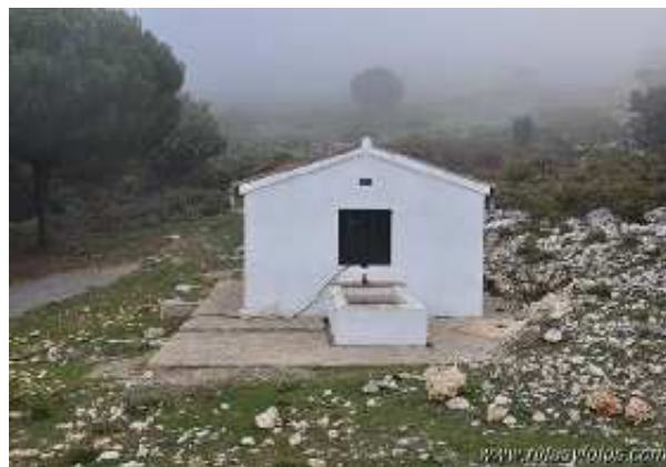
Aljibe del Cerro Coros (M. Limón Andamoyo, noviembre 2014)
