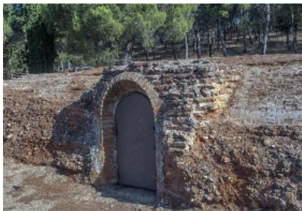
Aljibe de la Lluvia (J. Rubia González, octubre 2016)
