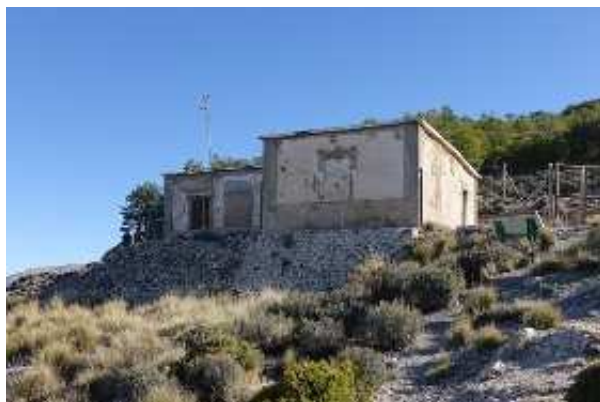
Casilla del Agua (M. Limón Andamoyo, noviembre 2023)
