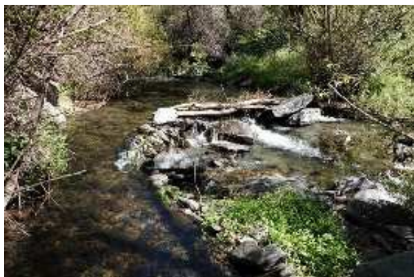
Toma de agua de la Acequia Nueva (M. Limón Andamoyo, julio 2023)
