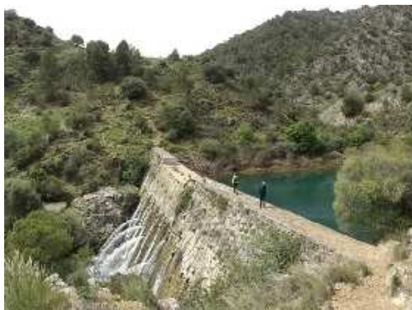
Dique del Nacimiento (M. Limón Andamoyo, marzo 2024)
