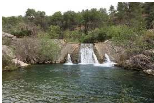
Dique del Molino Caído (M. Limón Andamoyo, marzo 2024)
