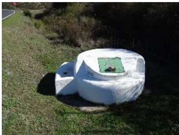
Vista del pozo (J. F. Martín Álvarez, noviembre 2022)
