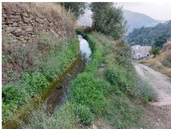
Acequia Nueva (M. Limón Andamoyo, septiembre 2021)
