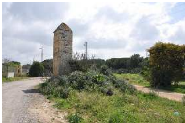
Torrecilla del Acueducto (M. Limón Andamoyo, marzo 2016)
