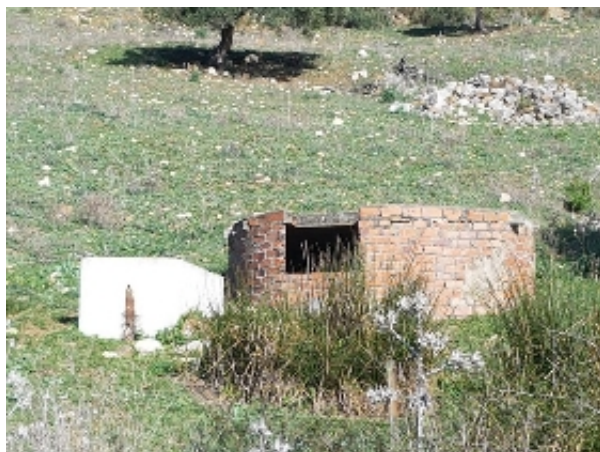
Pozo de la Colada de Casares (M. Limón Andamoyo, febrero 2022)
