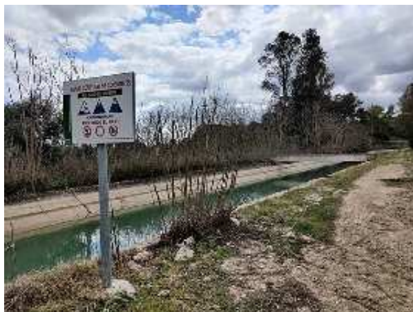
Canal de Tablellina a su paso por la Junta de los Ríos (M. Palomo Duarte, febrero 2022)
