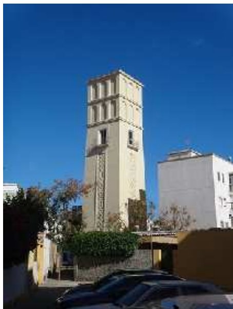
Torre del Agua (M. Palomo Duarte, noviembre 2014)
