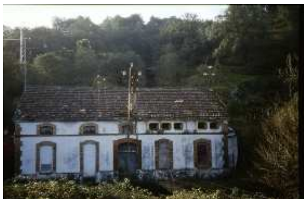
Edificio de la Central Eléctrica (A. Fernández Trisancho, octubre 2021)
