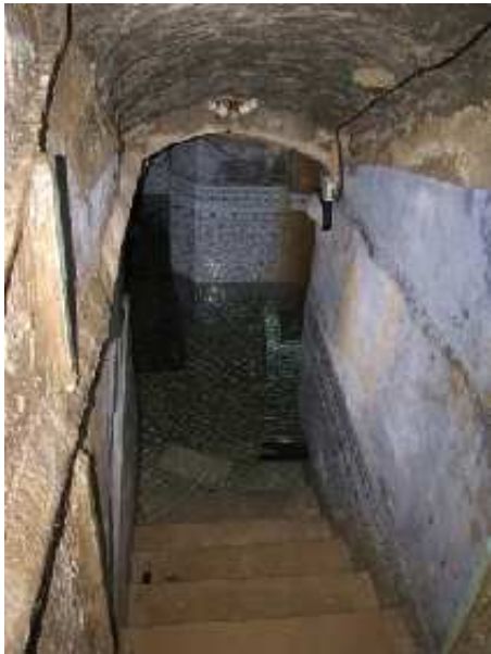
Aljibe o depósito donde se recoge el agua del pozo (CEIP San Francisco de Cájar, junio 2018)
