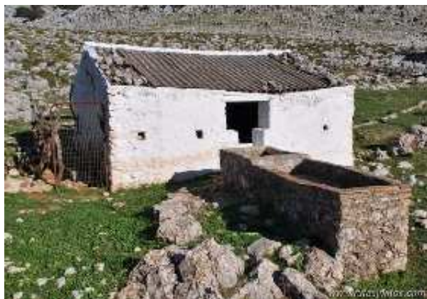
Aljibe y abrevadero del Puerto de Don Fernando (M. Limón, noviembre 2013)
