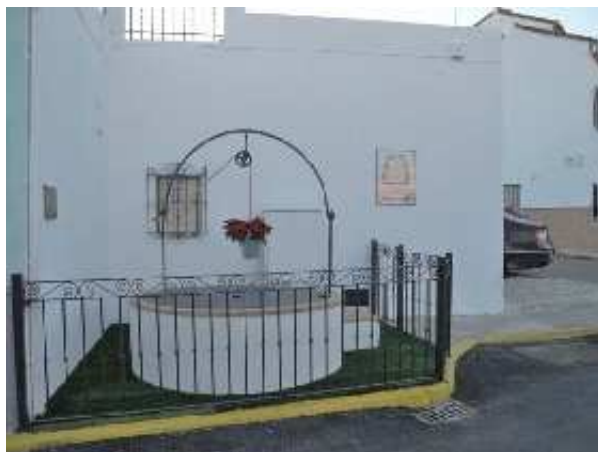
Pozo restaurado de la Arboledilla (A.C.P., enero 2021)
