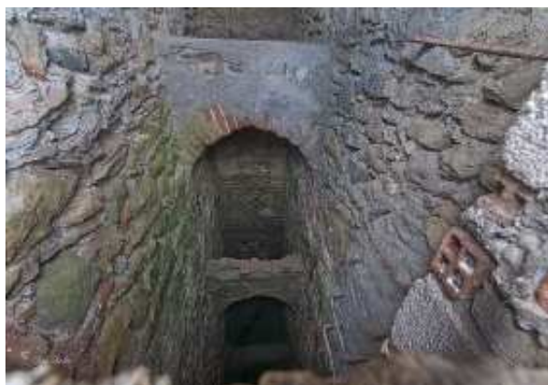
Estructura hidráulica de la Rambla de Cañizares (J. Rubia, octubre 2013)
