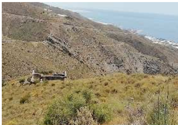
Panorámica del cortijo de Haza Blanca en ruinas (M. Paracuellos, mayo 2020)
