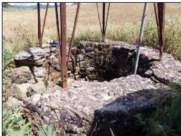
Pozo del Cortijo de Haza del Pino (F. Hidalgo Salido, junio 2020)
