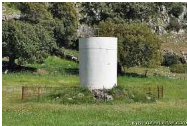
Fuente - aljibe del Pozuelo II (M. Limón Andamoyo, mayo 2015)
