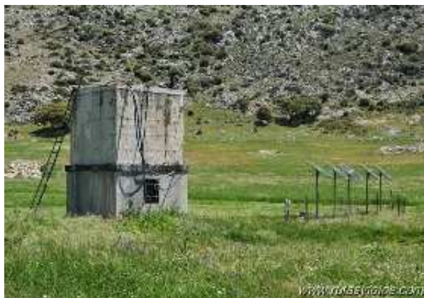
Fuente del aljibe del Pozuelo (M. Limón Andamoyo, mayo 2015)
