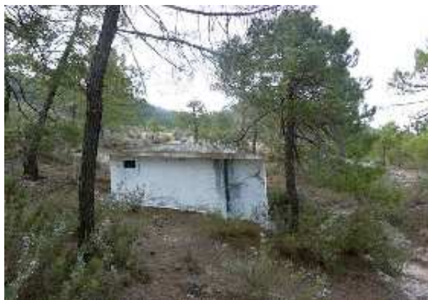
Captación Cañada Catena (J. D. Cano Cavanillas, abril 2015)
