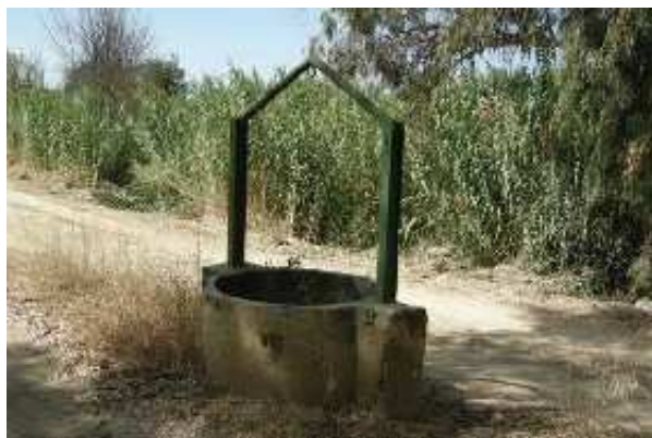
Poza del Lagar del Pozo (Ayuntamiento de Montilla, abril 2009)
